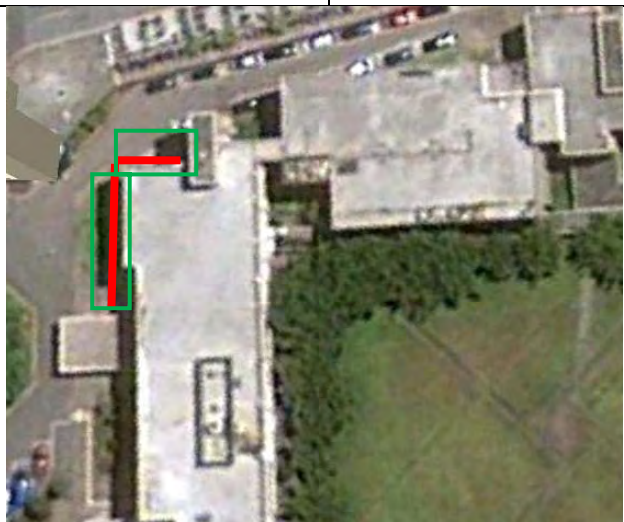
行政大樓 大門右側排水溝 (紅線標示，綠框處)
