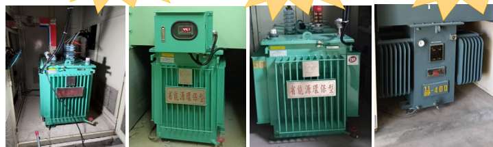
高壓變壓器汰換
