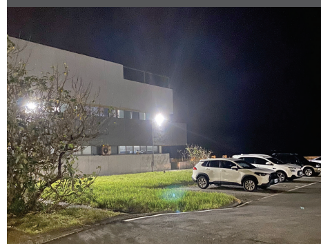
聲學實驗中心 加裝夜間照明燈
