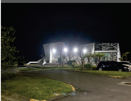
聲學實驗中心 加裝夜間照明燈
