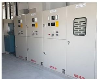
高壓變電站、全模鑄式銅導體220V匯流排及低壓配電盤示意圖
